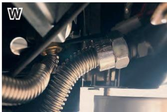
W) Anschluss Wellschlauch an Ventileinheit (der Anschluss befindet sich auf der rechten Seite unter der Bedienblende)
